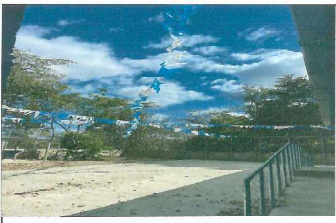
Foto 4: MEJORAMIENTO DE TECHADO DE PATIO.
