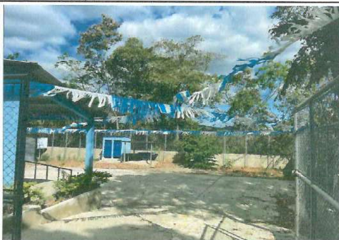
Foto 2: MEJORAMIENTO DE TECHADO DE PATIO.
