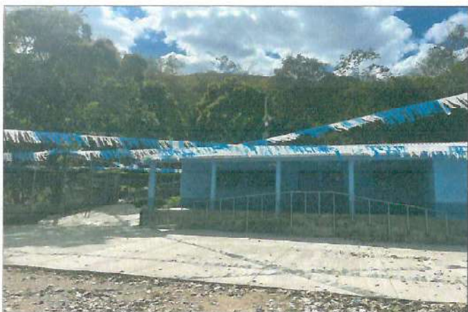
Foto 3: MEJORAMIENTO DE TECHADO DE PATIO.
