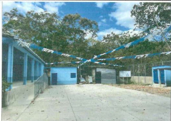
Foto 1: MEJORAMIENTO DE TECHADO DE PATIO.
